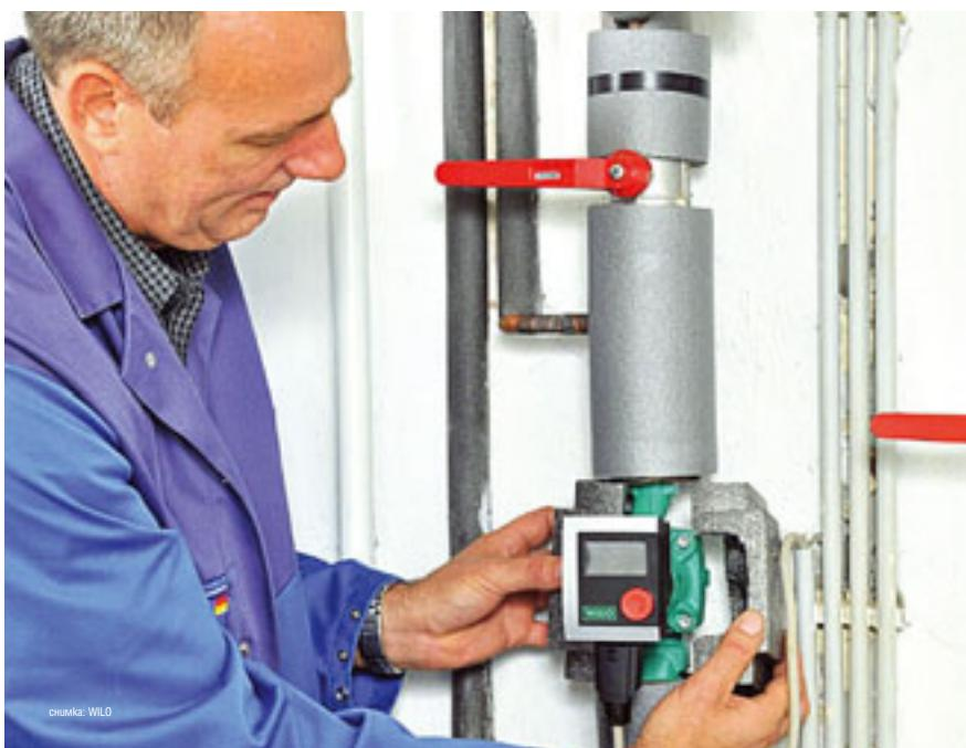
Индексът на енергийна ефективност (EEI) е показателят, по който се определя, кои помпени модели ще могат да се използват в бъдеще. Той се определя според метода на изчисление, дефиниран в Регламента (ЕО) 641/2009. Сравняват се различните консумирани мощности в рамките на един товарен профил с една средно-статистическа референтна помпа.
