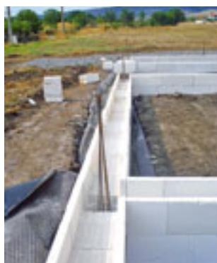
ВСЕЛА България – производител на YTONG, обогати асортимента си с нов продукт – това са иновативните блокчета с отвори. Те са част от цяла строителна система, която играе важна роля при оптимизиране и ускоряване на строителния процес.
